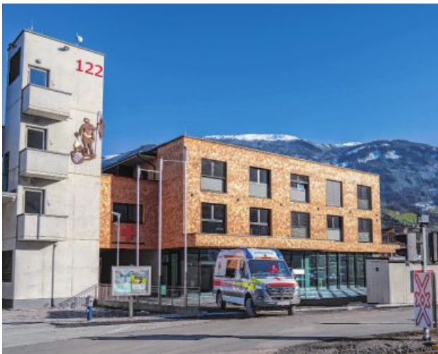
Der neue Stützpunkt in Kaltenbach wurde von den Bergbahnen Hochzillertal errichtet, das Rote Kreuz ist Mieter. Foto: Rotes Kreuz/Mader
